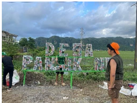
Gambar 5. Proses pemasangan botol-botol ecobrick pada gapura.
