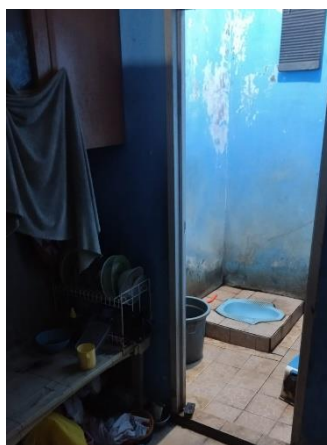
Gambar 1. Kondisi Kamar Mandi
