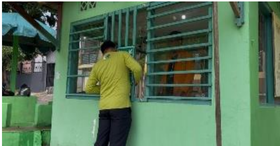
Gambar 3. Proses Pemasangan Masterpoint di Poskamling RT.39
