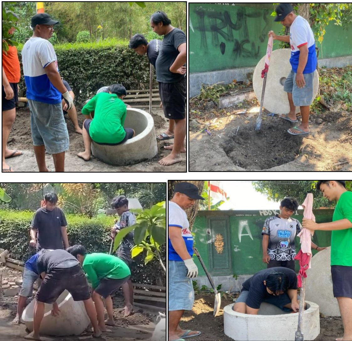
Gambar 3. Kegiatan Pembangunan Teba Modern
