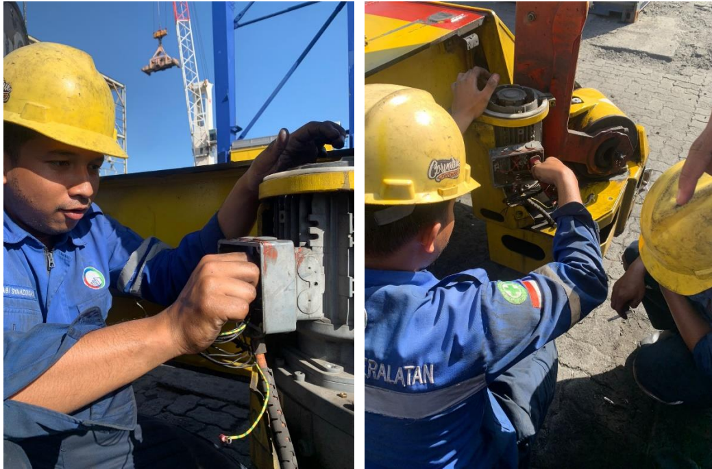
Gambar 1. Peserta melakukan pemeliharaan motor listrik
