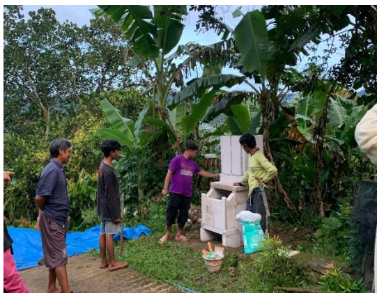
Gambar 1. Proses Pembuatan Incinerator
