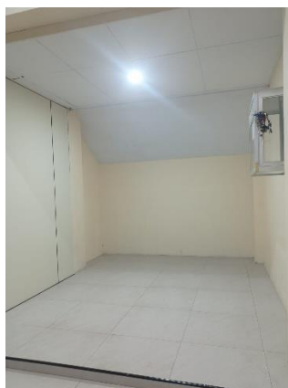
Gambar 1.8 Kondisi Ruangan Sebelah Kanan
